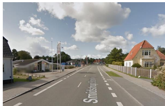
Figur 43. Eksempel på smalle kantbaner fra Smidstrup Strandvej nordøst for Helsingevej (Google Maps).
