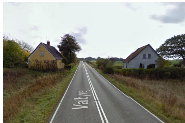
Figur 20. Indsnævring på Valbyvej nr. 50 og 59 med kig mod syd (Google Maps).
