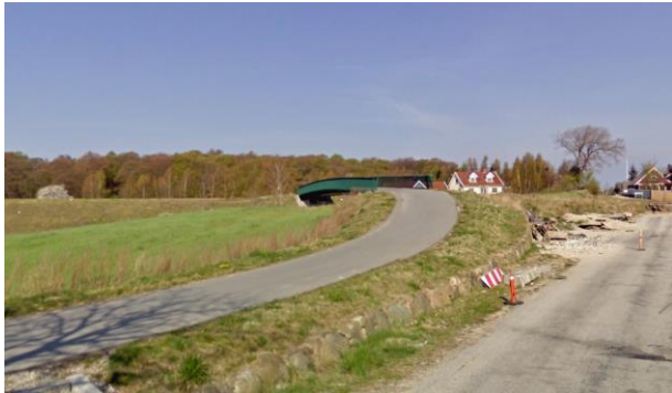
Figur 35. Dobbeltrettet cykel- og fodgængerbro over Ny Mårumvej set fra Schiwesvej mod nordvest (Google Maps).
